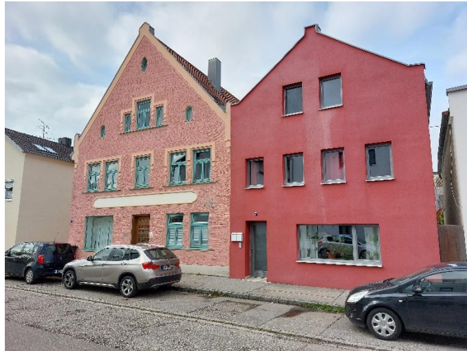
Brandstattgasse 6 (Bild links) Zweigeschossiger Giebelbau mit steilem Satteldach -- FlstNr. 101 [Gemarkung Dorfen]. Ortsbildprägendes Gebäude
