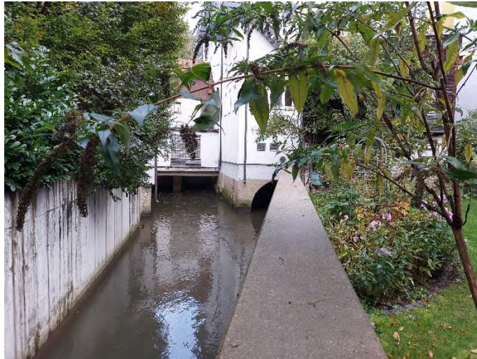
Mühlbach (Obermühlbach) Lauf des Obermühlbachs Nähe Johannisplatz 7a im Bereich der historischen Stepfenmühle Historisches Gewässer
