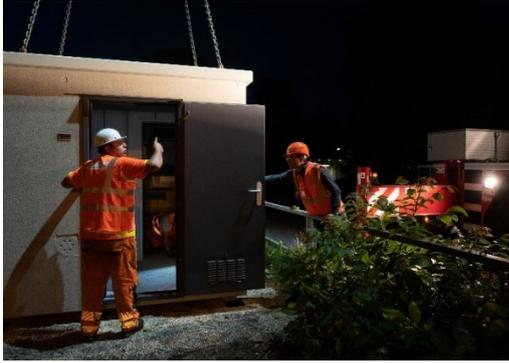
Für die neue Stellwerkstechnik werden Modulgebäude errichtet.
